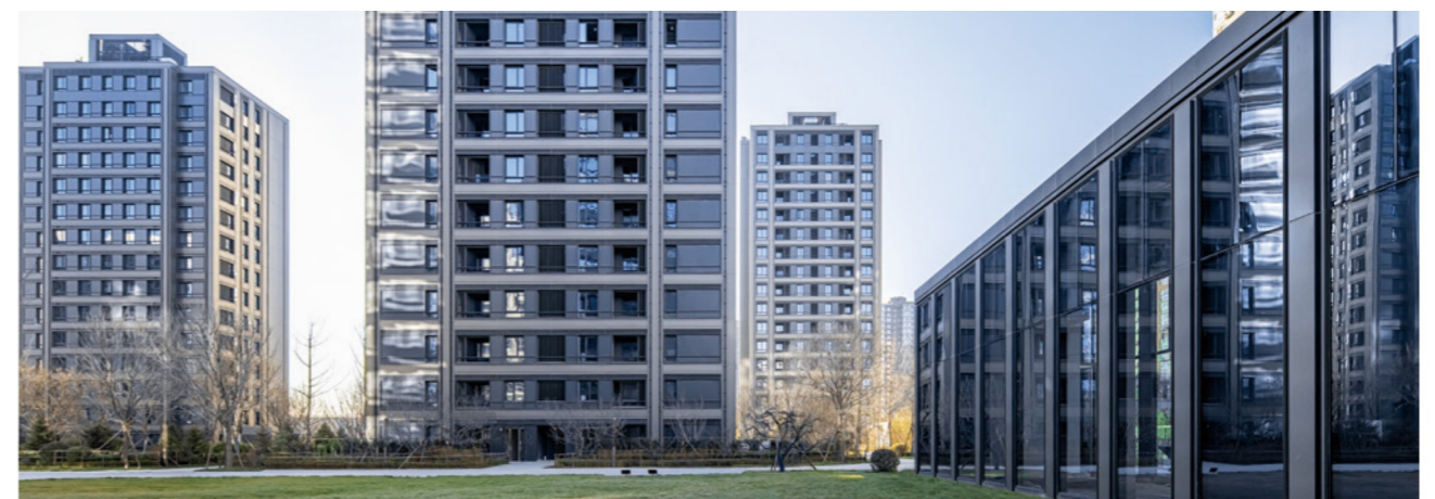
Suministro de agua a viviendas
